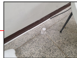
배관 철거 후 마감
