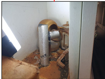
급, 배수배관 철거 후 마감
